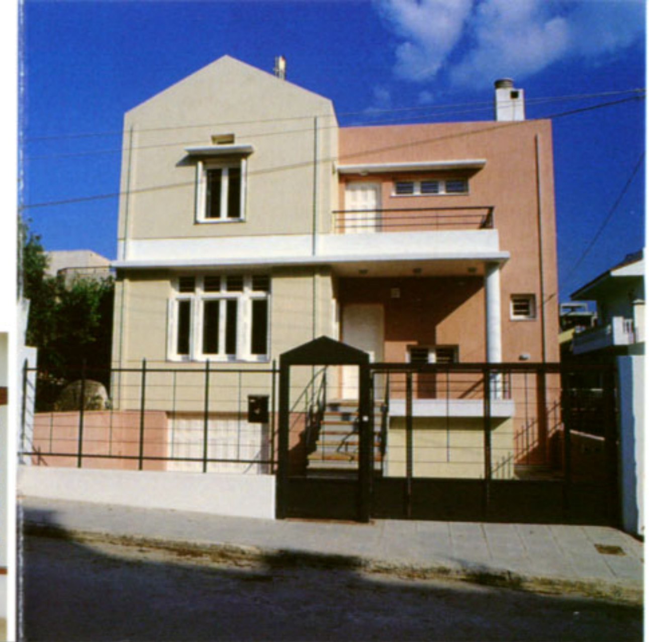
Κατοικία στα Βριλήσσια Δωδεκανήσου 54 1991-92
