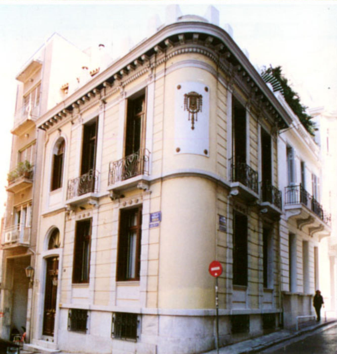
Συντήρηση κατοικίας στην Πλάκα και μετατροπή της σε οικο γούνας (κατασκευή) Πατρώου 2 1984
